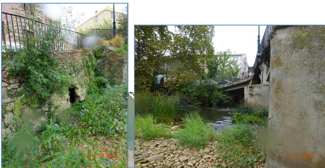
**Ilustración 30:** Salidas de pluviales de gran tamaño y con amplias áreas de recogida, a ambos lados del cauce del río Ega, a escasos metros del puente del Azucarero, prácticamente debajo de él mismo.
