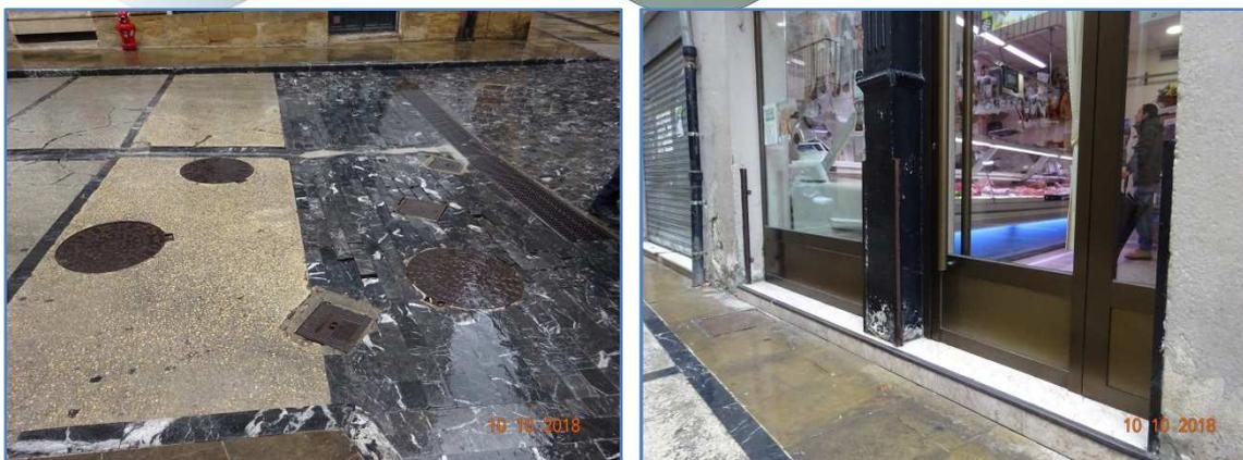
**Ilustración 25:** Arquetas de pluviales y medidas de protección de los establecimientos en la calle Mayor.
